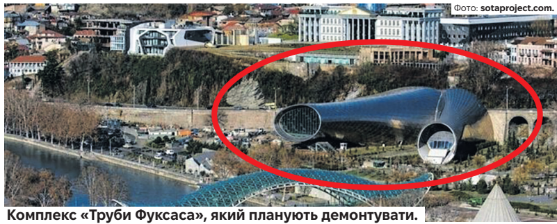
Комплекс «Труби Фуксаса», який планують демонтувати.
