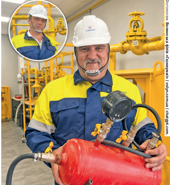
Юрій Росковінський та Андрій Пишук дали списаному вогнегаснику друге життя – і створили корисний пристрій для перевірки газового обладнання.
