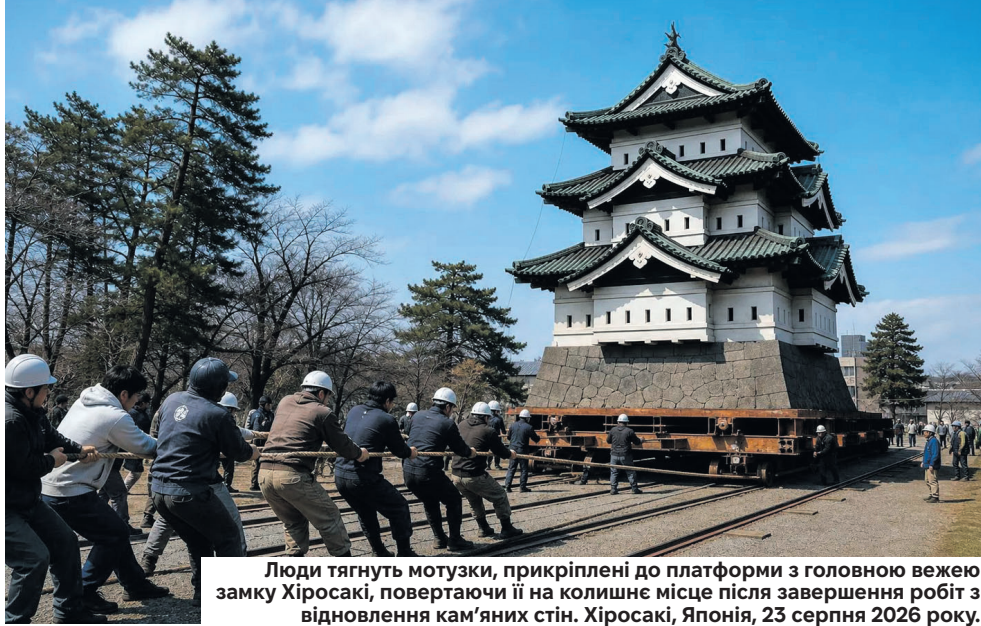
Люди тягнуть мотузки, прикріплені до платформи з головною вежею замку Хіросакі, повертаючи її на колишнє місце після завершення робіт з відновлення кам'яних стін. Хіросакі, Японія, 23 серпня 2026 року.
