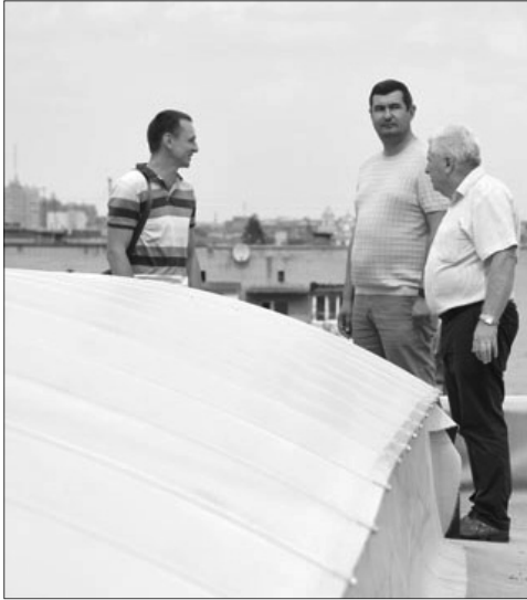
Леонід Карабан та Григорій Недопад інспектують ремонт даху будівлі.
